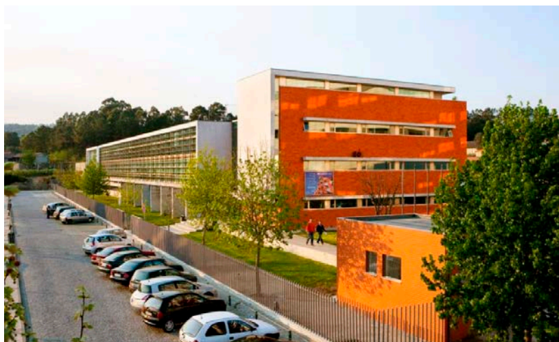
Imagem 3: Edifício da Escola Profissional Amar Terra Verde
